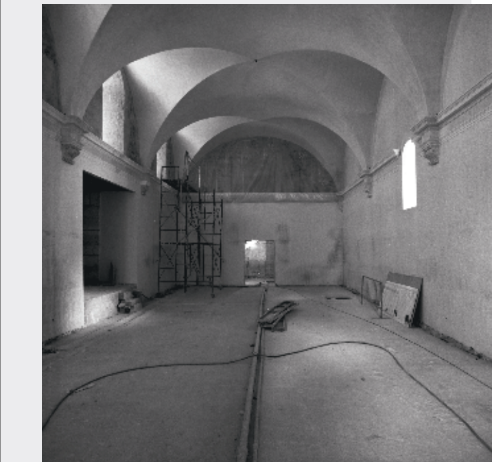
Ricardo González: Sala Gil de Hontañón en obras , c.2001.
